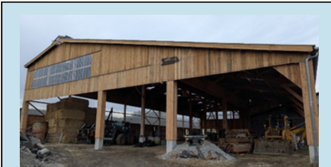
Il y a quelques années, Benoît a entrepris de construire une stabulation de 1300 m 2 , et a réalisé seul ! la maçonnerie, la plomberie, l'électricité et le bardage bois.
